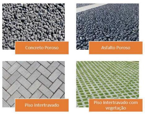
Figura 44 – Tipos de pavimentos permeáveis Fonte: Aguiar (2022)
