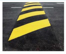
Marcas oblíquas, inclinadas, no sentido horário, a 45º em relação à seção transversal da via, com largura mínima de 0,25m, pintadas na cor amarela e espaçadas de no máximo de 0,50 m, alternadamente, sobre o dispositivo, admitindo-se, também a pintura de toda a ondulação transversal na cor amarela, assim como a intercalada nas cores preta e amarela, no caso de pavimento que necessite de contraste mais definido
