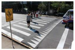
Demarcação em forma de triângulo, na cor branca, sobre o piso da rampa de acesso da travessia elevada; e demarcação de faixa de pedestres do tipo "zebrada" com largura (L3) entre 4,0m e 6,0m na plataforma da travessia elevada, conforme critérios estabelecidos na Resolução nº 738 do CONTRAN
