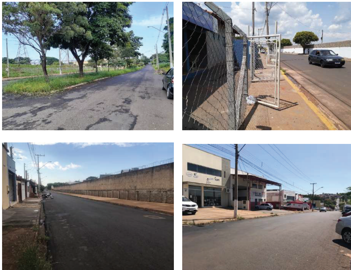
Figura 45 - Exemplos de vias coletoras e arteriais observadas em inventários físicos sem sinalização adequada.
