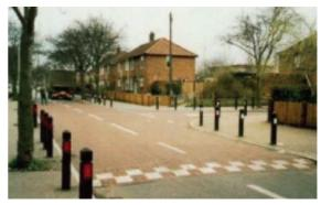
Figura 53 - Perspectiva de implantação de travessia elevada (esq.) e travessia leito carroçável elevado em cidade do exterior (dir.)
