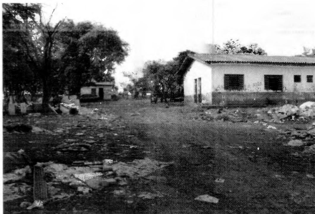
Figura 16 - Vista lateral da entrada da Central e da casa que atualmente é ocupada por uma família
