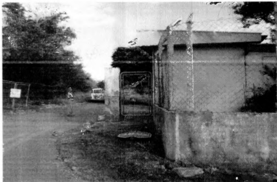
Figura 13 - Entrada da Central
