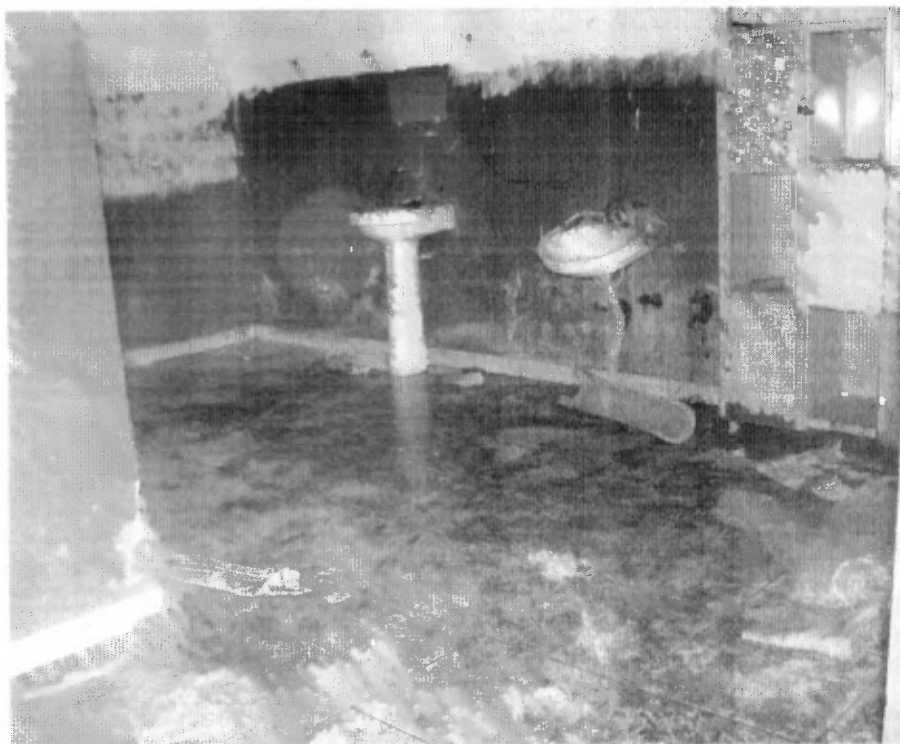
Figura 20 - Estrutura dos vestiários
