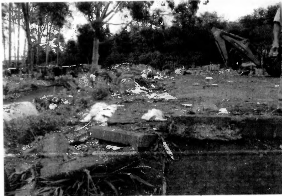
Figura 6 - Guias quebradas no local de operação do transbordo
