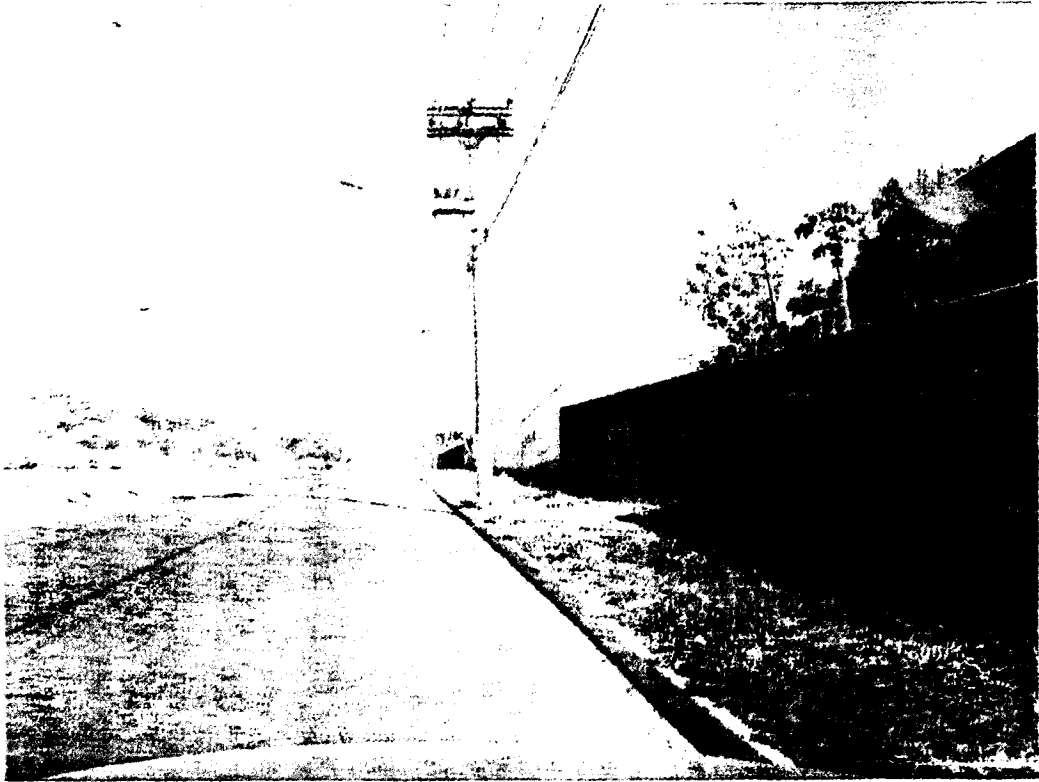
AV. IVANIL FRANCISQUINI CALÇADA RES. VILAGE VERDE
