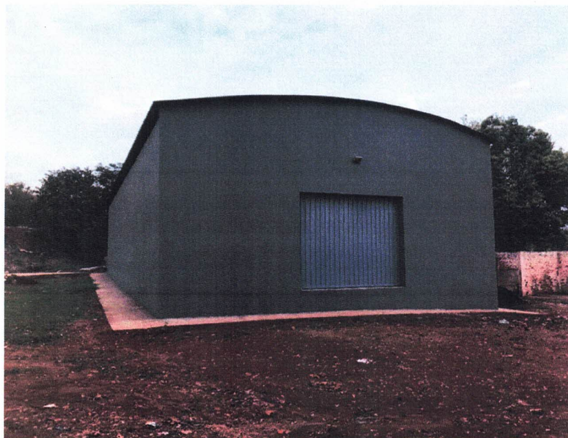
Figura 3 – Barracão reformado – parte externa
