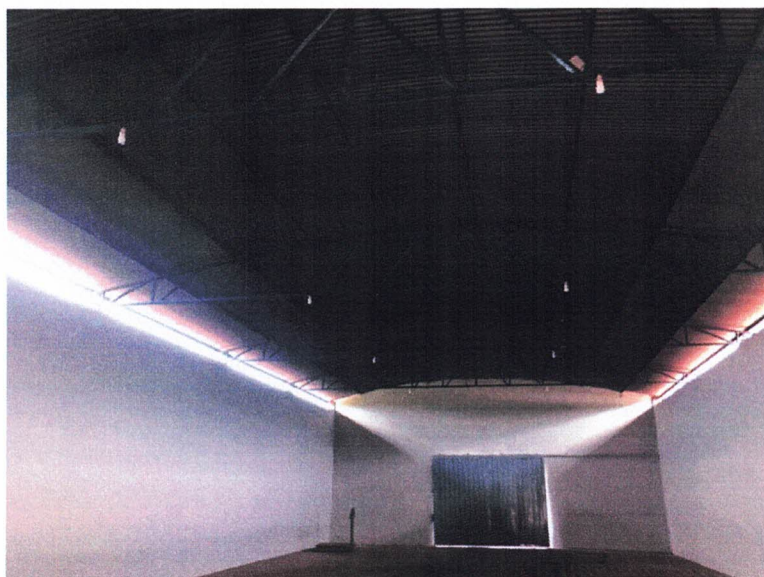
Figura 2 – Barracão reformado – parte interna
