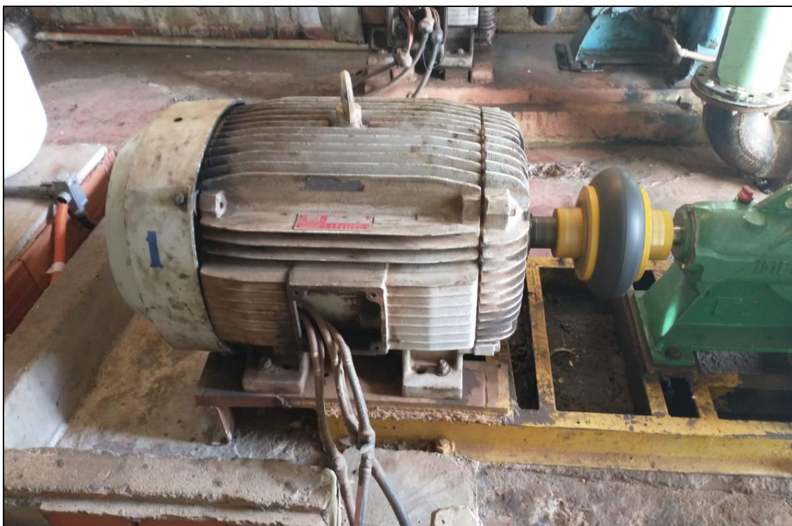
Figura 12 – Sistemas Motrizes - Sistema 1 – Motor 100CV – Bomba ETA
