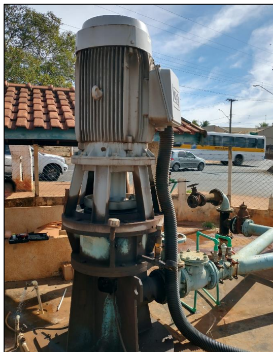
Figura 14 – Sistemas Motrizes - Sistema 3 – Motor 200CV – Bomba P8 Rafaela
