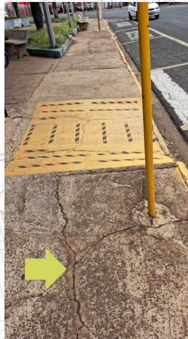
Fissuras no piso externos em diversos pontos
