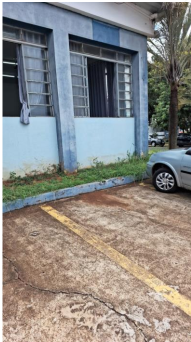
Fissuras no piso externos em diversos pontos
