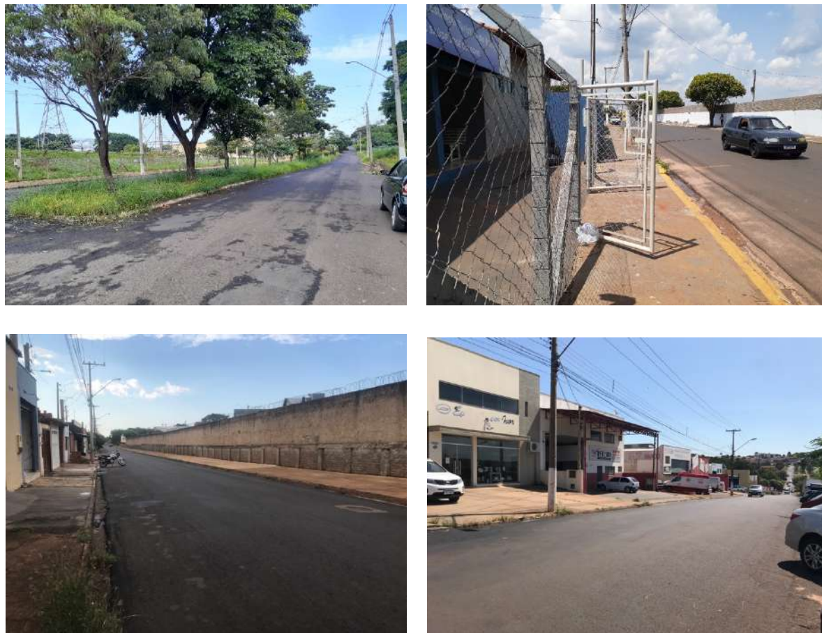
Figura 45 - Exemplos de vias coletoras e arteriais observadas em inventários físicos sem sinalização adequada.
